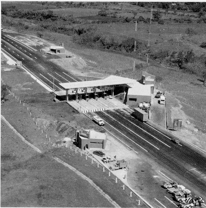
Caseta de peaje.
